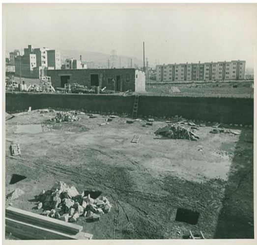
IMATGE 11: OBRES DE CONSTRUCCIÓ DEL MERCAT LA FLORIDA 146 , 1956
