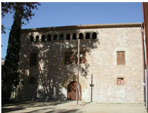
1. Estat actual de l'edifici de l'Harmonia, coneguda en època medieval com a Torre Blanca. Als terrenys d'aquesta es va construir el petit hospital de camí, que va rebre el nom de l'Hospitalet.
