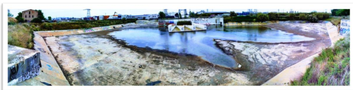
Foto 15. . Panoràmica de la bassa de la Torre gran (autor: Tomàs Ballesteros)
