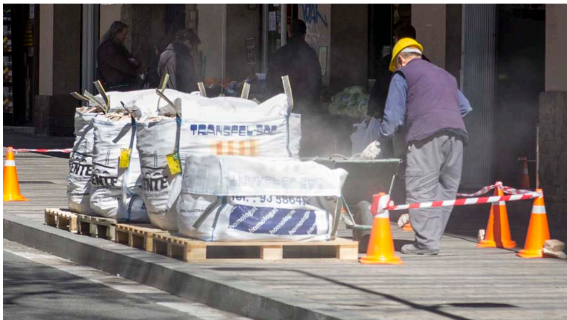
Figura 65 Activitat de construcció/demolició a la via pública. Font: BCNecologia.
