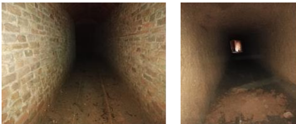
Imatges del primer tram de les galeries
