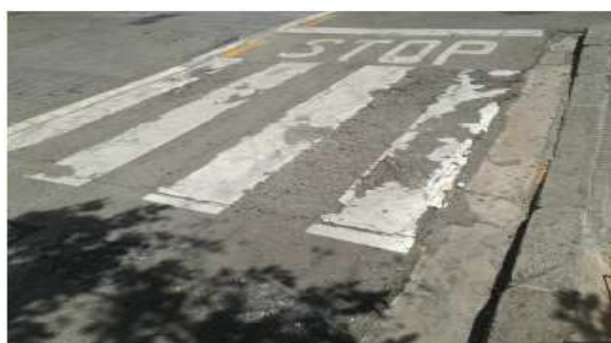
CARRER LA MINA
